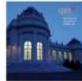
201601.18 Visite du chantier de La BOVERIE
